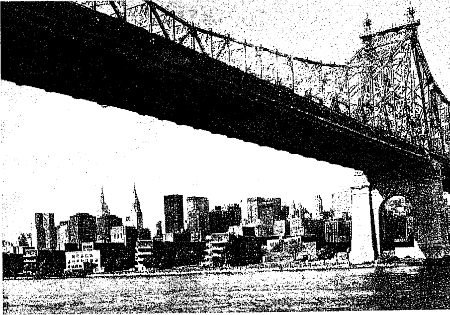
(جسر كوينزبروف (Queensborough) عبر النهر الشرقى وتظهر فى الصورة ناطحات السحاب )
