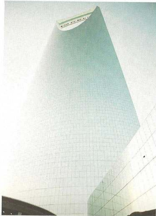
يهيمن برج المدينة الجذاب على خط الأفق حيث يبلغ ارتفاعه 303 أمتار. عندما افتتح في تشرين الأول/أكتوبر 2003 أصبح أعلى مبنى في المملكة العربية السعودية. http://www.ibtesama.com/vb
