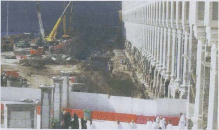
أعمال التحضير والهدم
