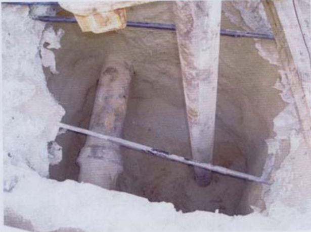
عملية الحفر لمنطقة جبل المروة
