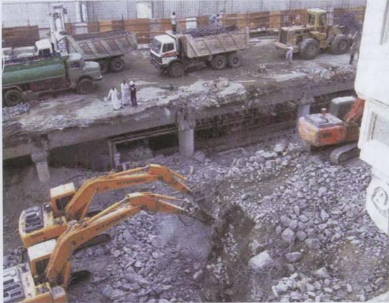
أعمال الهدم لتهيئة بناء التوسعة
