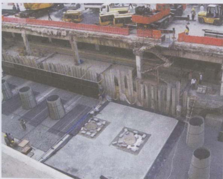
من أعمال الإنشاء
