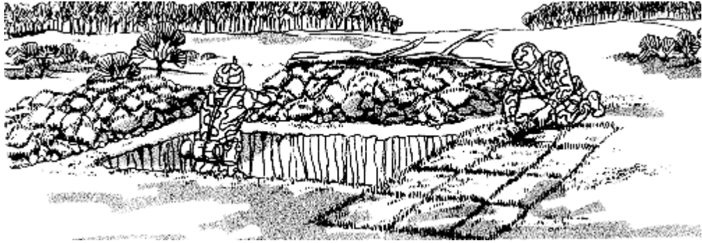
صورة ١٧: القيام بتعمويه سقف الخندق
