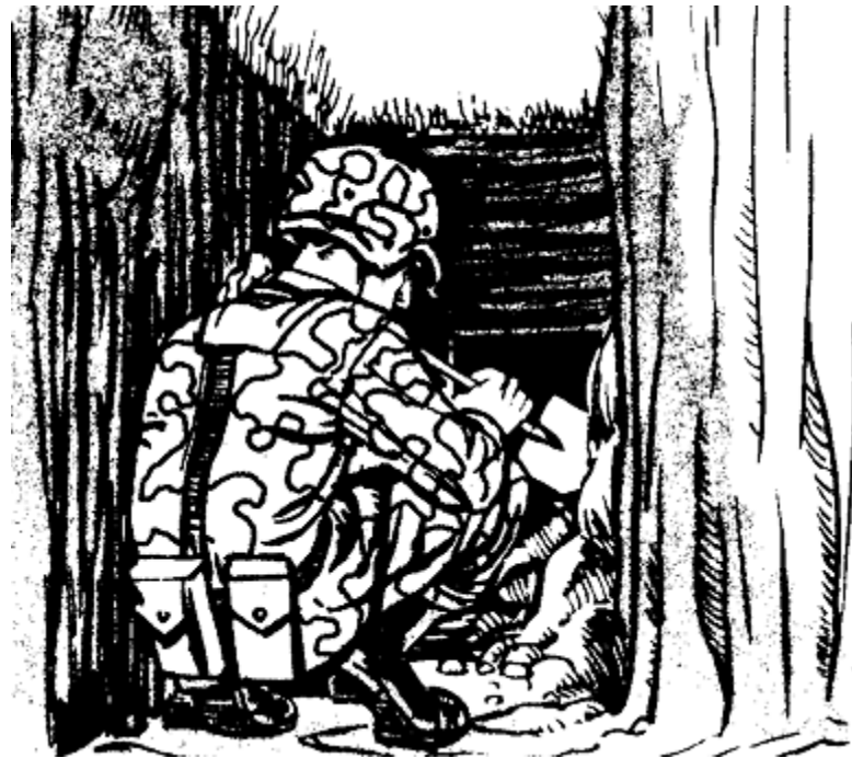
صورة ١٨: حفر الخندق من الداخل تحت السقف الذي تم إنشائه
