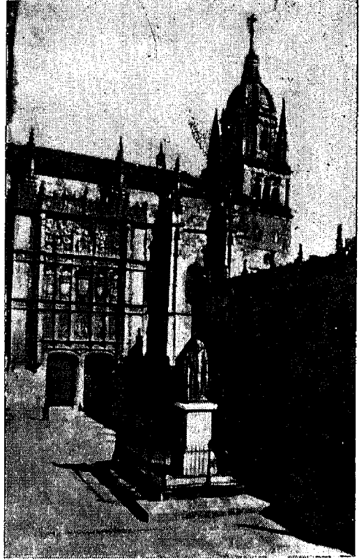
شلمنقة . بناء الجامعة القديم
