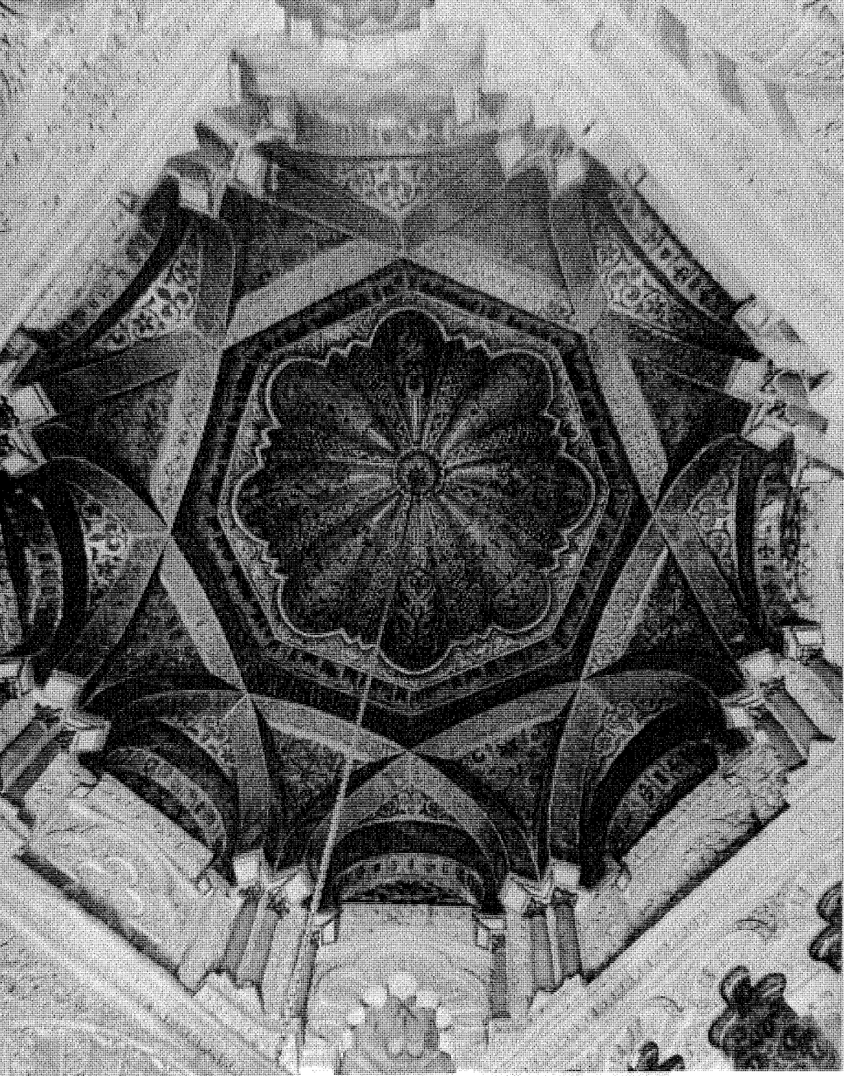
القبة الوسطى فوق بلاطة المحراب. انظر إلى العصبية الحجرية التي تقوم القبة عليها. تلك هي بداية طراز العمارة القوطي.
